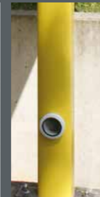
Entwässerung durch Stütze
